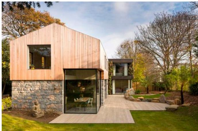
1. Socle recouvert de maçonnerie surmonté d'un parement léger en bois.
