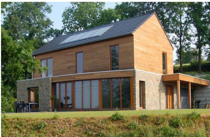
3. Socle recouvert de maçonnerie surmonté d'un parement léger en bois.
