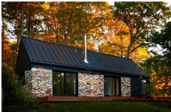
4. Rez-de-chaussée en maçonnerie surmonté d'un parement léger en revêtement métallique
