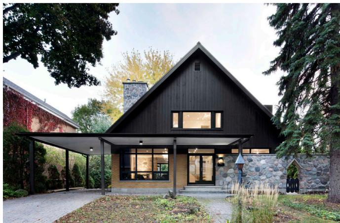
2. Rez-de-chaussée en maçonnerie et en pierre des champs surmonté d'un parement léger en bois.
